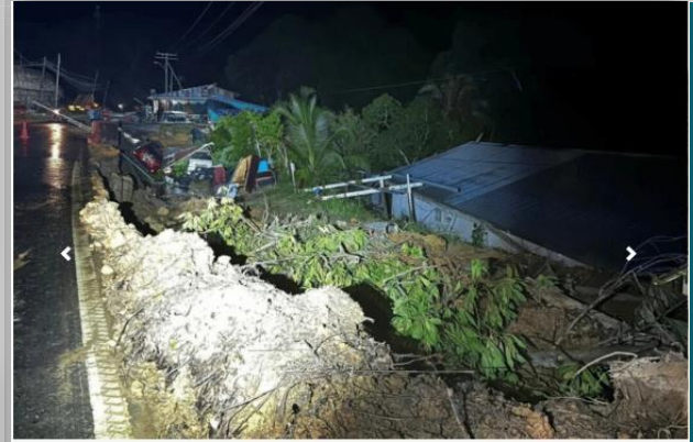
Keadaan rumah dan kenderaan yang rosak akibat kejadian tanah runtuh di Kampung Madsiang, Jalan Tambunan Penampang, Sabah, pada awal pagi 18 September. -Foto JABATAN BOMBA DAN PENYELAMAT MALAYSIA.
